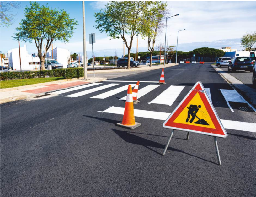
Reparação de pavimentos betuminosos na cidade
