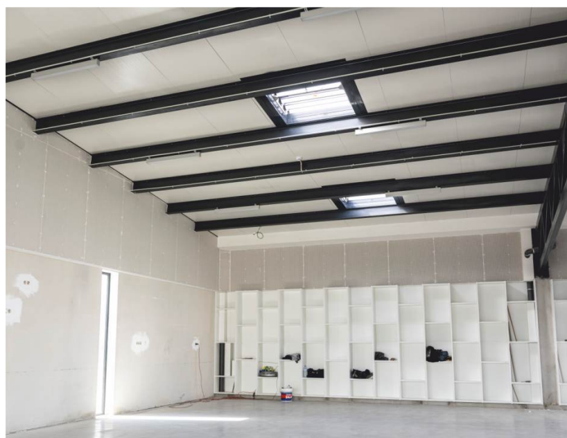
Remodelação e modernização da Escola Básica n.º 2
