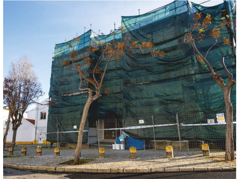
Reabilitação do edifício n.º 16 da Rua do Bairro Marítimo
