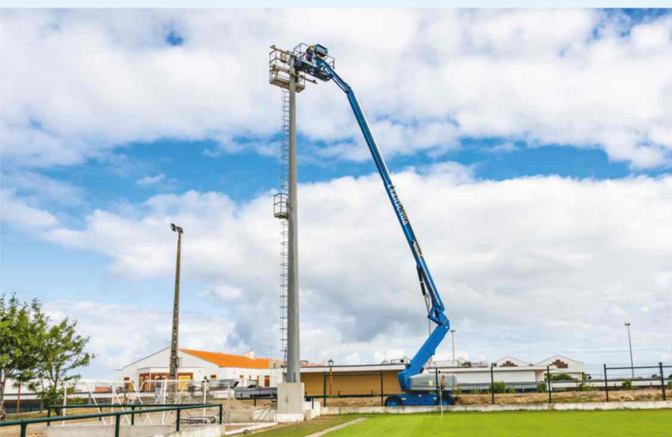
Remodelação da iluminação dos campos de jogos do Estádio Municipal
