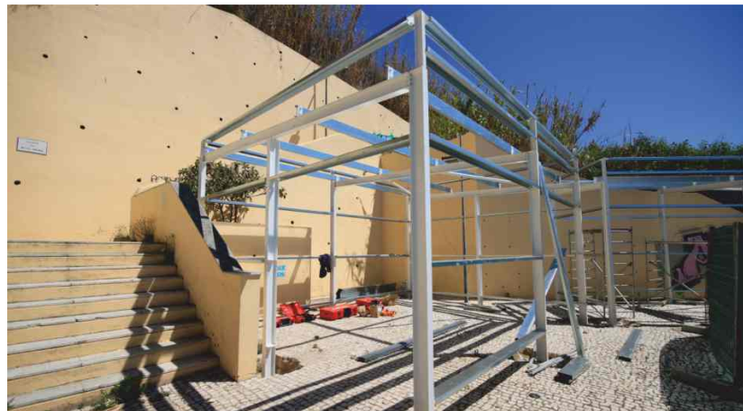
Pavilhão em construção junto ao Caminho das Bicas
