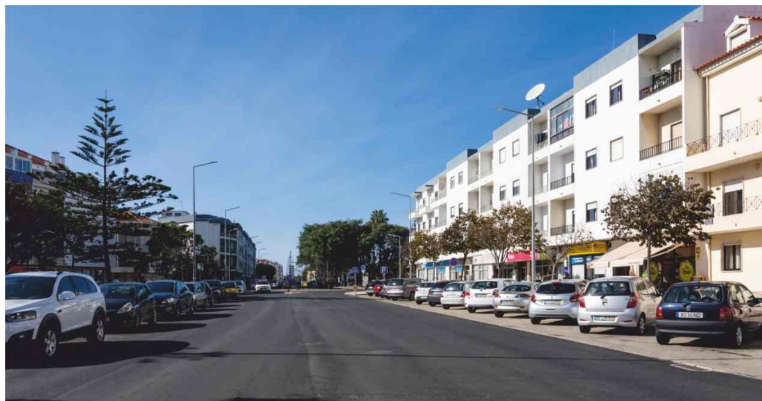
Reparação de betuminosos
