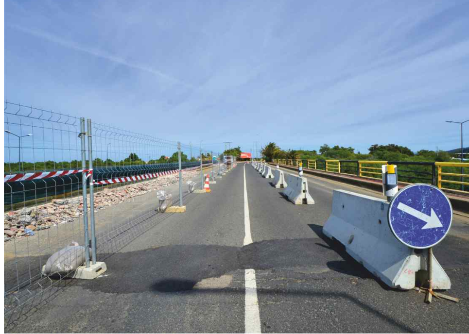
Viaduto junto à Costa do Norte
